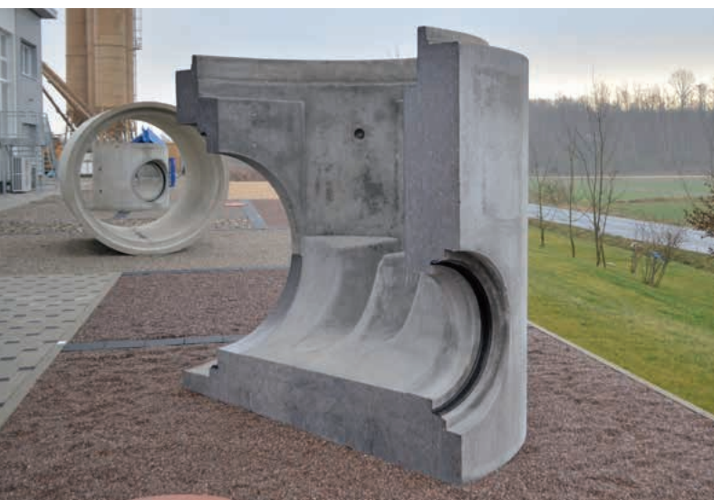
Schnitt durch ein monolithisch erstelltes Schachtbauwerk
